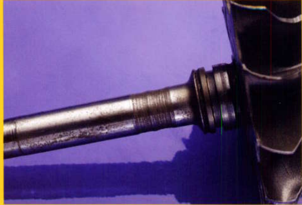
7.20 Points d'encastrement usés sur l'arbre de turbine
